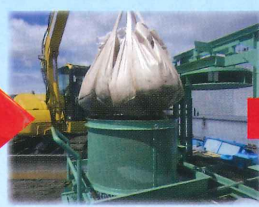
処理土を透水性バッグ等へ詰め脱水機へ
