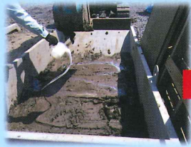
流動性のある汚泥に改質剤を混練
