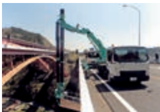
橋梁補修工事
