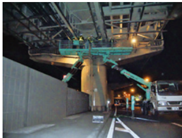
橋梁補修工事
