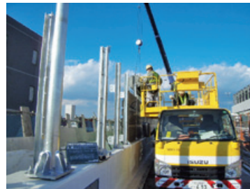
遮音壁設置工事
