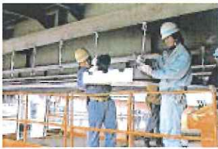
5. 裏面吸音板の取付け
