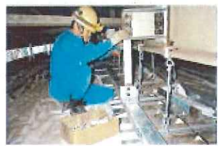
6. 吊り資材などの取付け
