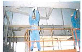
4. 専用吊り金具取付
