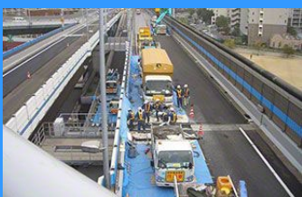
伸縮継手補修工事
