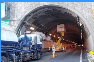
トンネル補修工事
