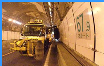
トンネル清掃作業
