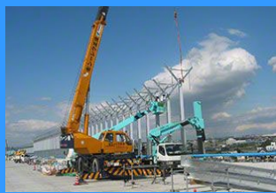
遮音壁設置工事
