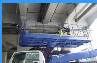
床版補修工事
