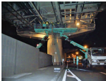
橋梁補修工事
