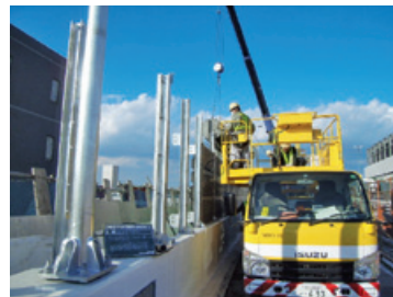
遮音壁設置工事
