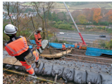
災害復旧工事
