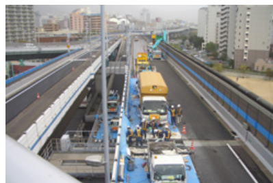
伸縮継手工事（道路維持管理業務）
