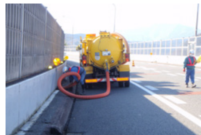
排水樹清掃（道路清掃業務）
