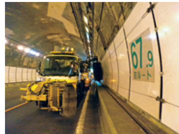
トンネル壁面清掃
