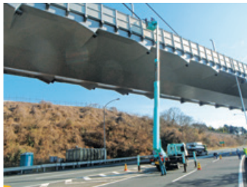
橋梁点検作業
