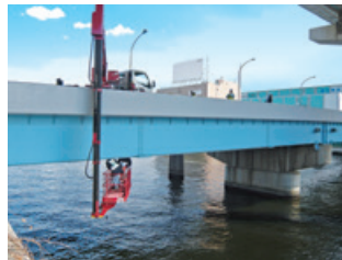
橋梁点検、補修工事
