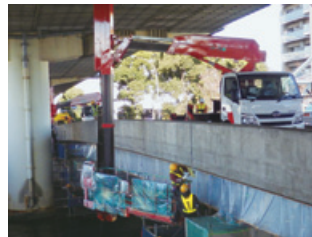
橋梁補修工事
