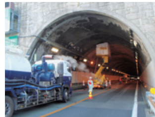
トンネル補修工事
