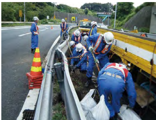
事故復旧工事
