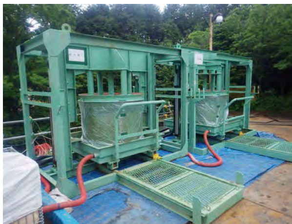
ため池水を加圧型脱水機にて汚濁物と水を分離
