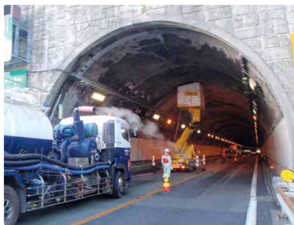
トンネル補修工事
