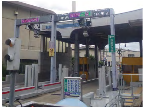
現在の料金所（阪神高速道路・深江浜料金所）
