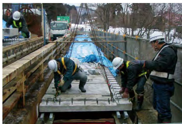
仙台事業所 橋梁補修工事
